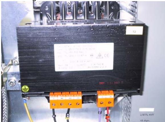
Der in Bild 1 gezeigte 2,5 kVA Trafo muss bei 230V auf der Primärseite mit einem C 50 A Schutzschalter abgesichert werden. Das ist der 5 fache Nennstromwert, weshalb noch eine
