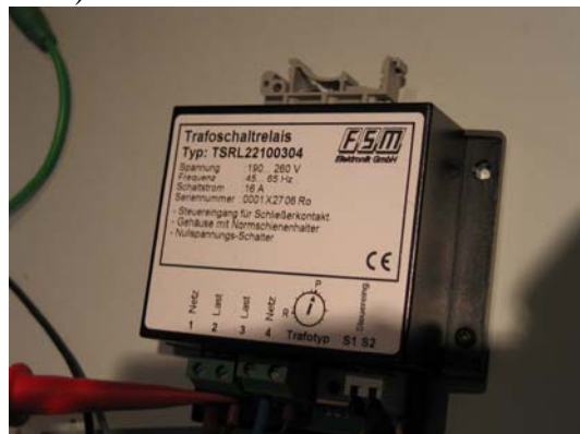
Bild 18 , Mit dem Trafoschaltrelais, mit Option Nulldurchgangsschalter, läßt sich das Trafonetzteil gut einschalten. ( Hier noch eine Standard TSRL Nummer, mit Steuereingang und Poti.)
